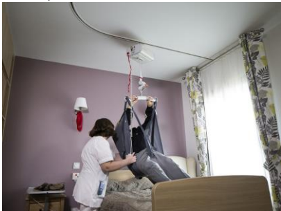
Rail plafonnier dans les chambres des résidents
